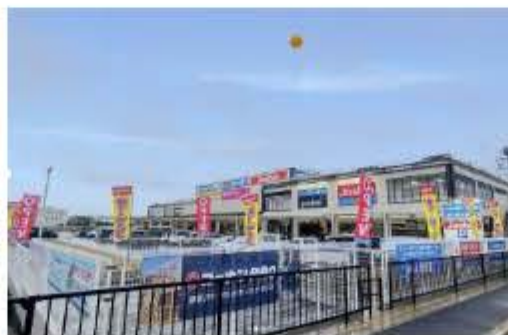
コーナン草加松原店新築工事
