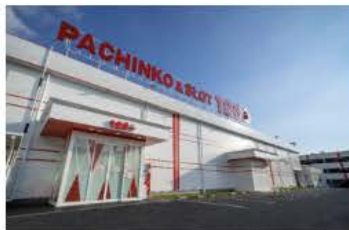
123+N羽曳野店新築工事
