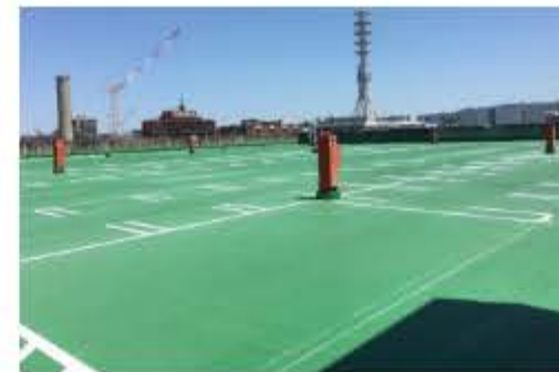
コーナンホーム寝屋川店 防水工事
