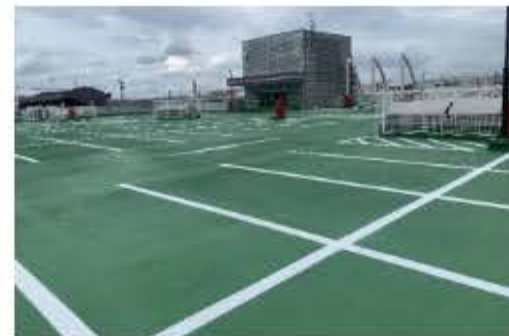
コーナンホーム蟹江店屋上駐車場 防水工事
