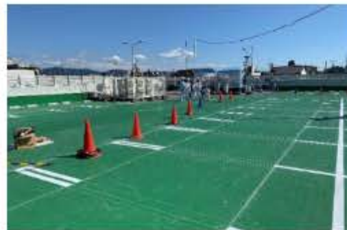
コーナンホーム伏見横大路店 防水工事
