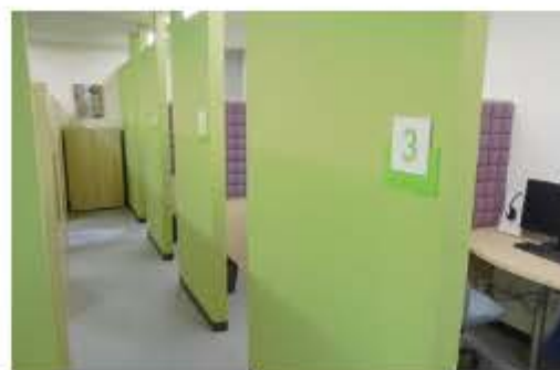
Gaba 三件茶屋 校内改修工事
