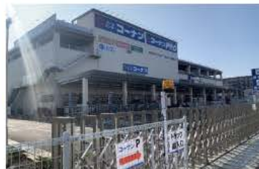
コーナン足立扇店新築工事
