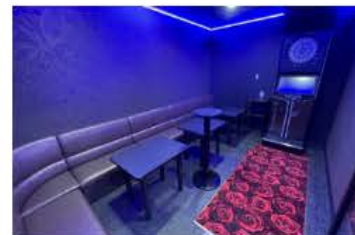
五反田カラオケダーツバー内装改修工事
