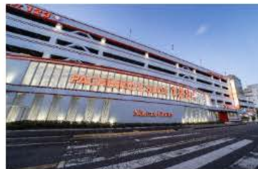
123+N布施店新築工事
