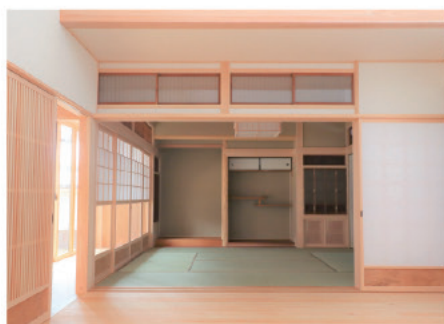
桧・戸建て住宅 床、建具
