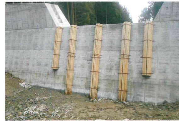
水抜き閉塞防止工
