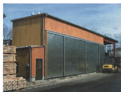
低温(養生)乾燥機 1基 乾燥容量 100 m 3 最高温度 50℃
