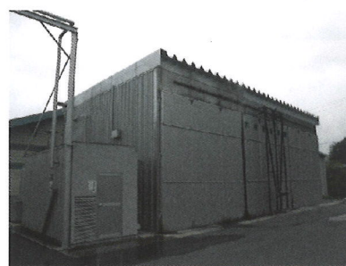
中温乾燥機 1基 乾燥容量 250 m 3 最高温度 80℃
