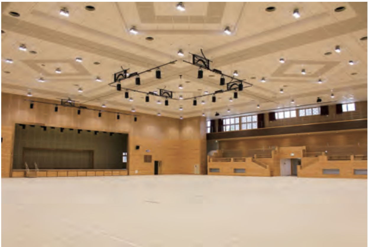
▲沖縄空手会館 マツ集成(無節)フローリング 18 mm 1,820 m 2 防虫防蟻処理
