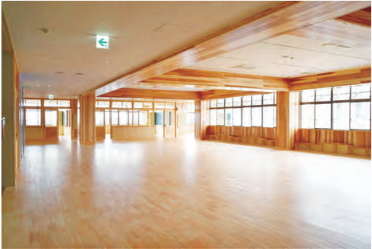
▲宮崎県上新田小学校 ヒノキユニットフローリング(上小節) 15 mm 1,627 m 2 (光触媒フローリング)
