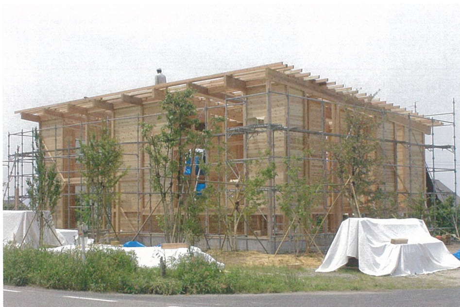
左／鳥取のN邸の建て方全景。落とし込み構法だと棟上げの時に既に大体の壁の様子がわかります。
