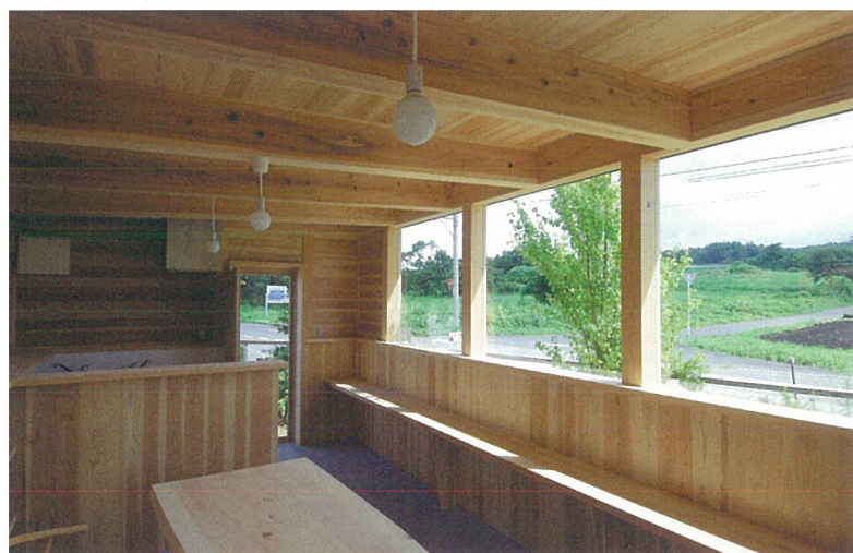
神奈川のM邸。夏の日差しを遮り家を雨から守る深い軒は強いJパネルならではの。持ち出した梁にしっかりと金物で留めて風の吹き上げを押えています。軒裏の表情も美しくなります。
