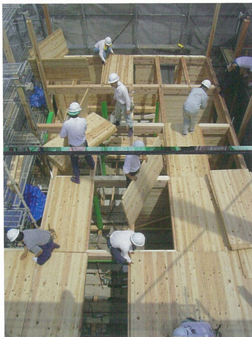
建て方の様子。Jパネルで床を造りながら工事を進めれば、足場にもなり作業性も安定します。
