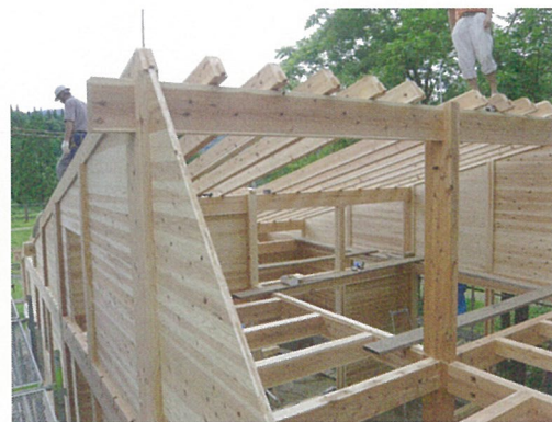
左／鳥取のN邸の建て方全景。落とし込み構法だと棟上げの時に既に大体の壁の様子がわかります。
