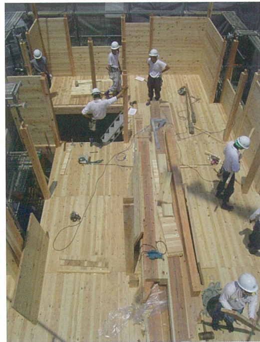
建て方の様子。Jパネルで床を造りながら工事を進めれば、足場にもなり作業性も安定します。
