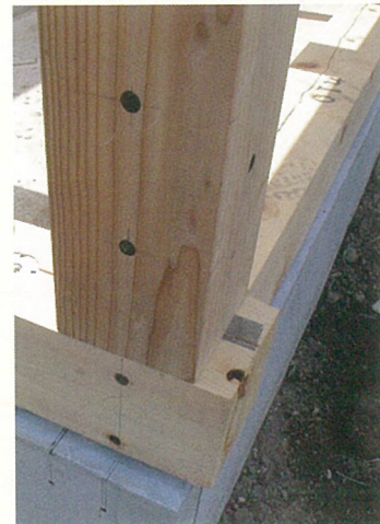
柱をセットしてピンを打ち込む。 見えるのはピンだけなのでスッキリします。
