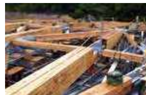
屋根フレーム
