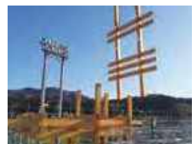
特殊木構造の現場施工
