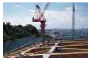
二次部材取付け
