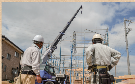
木工事請負(建築全般)
