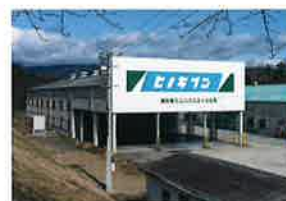
三重CLT工場
