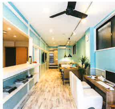
リフォーム工事（民泊改修）
